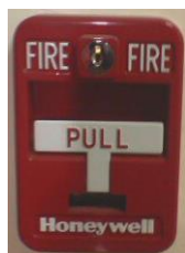
Alarma de incendios (interruptor)
