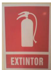
Ubicación del extintor de incendios
