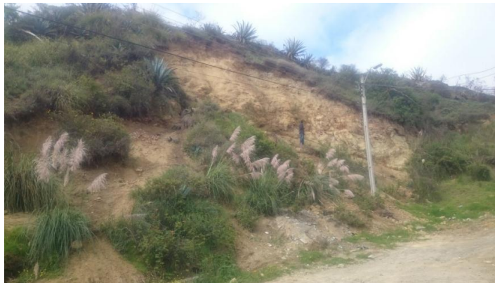
Figura 12: Talud “Ciudad Victoria”
