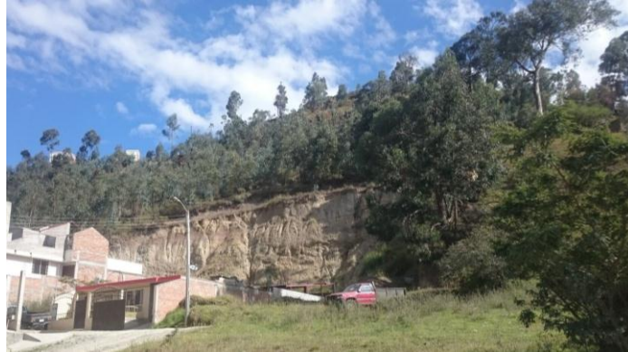
Figura 11: Talud “Las Pitas”
