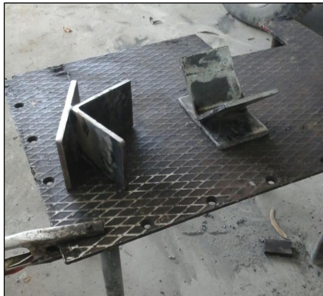
Figura 52. Confección de cabezales de aplicación de carga.
