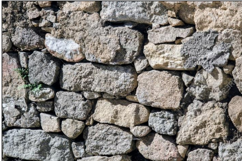
Figura 3. Mampostería de roca
