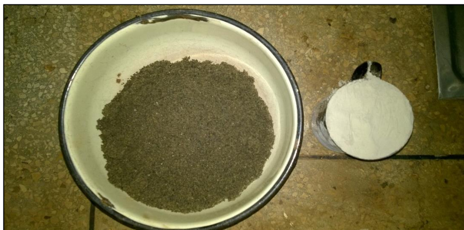
Figura 39. Mezcla de arena fina y cemento
