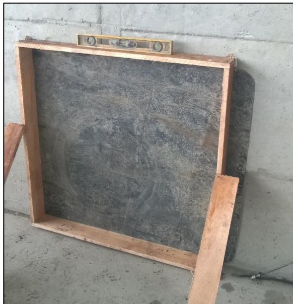
Figura 26. Construcción de pared modelo.
