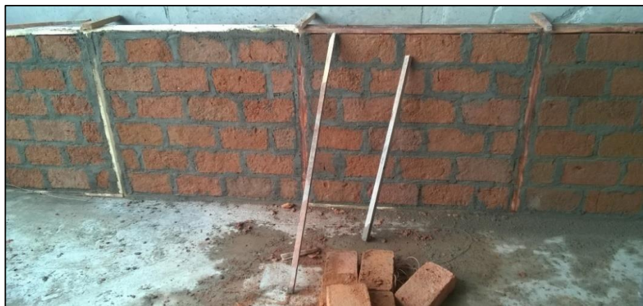
Figura 49. Muros de mampostería.
