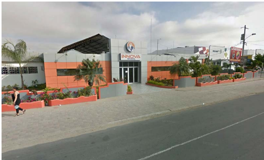
Figura 2: Entrada de la Unidad Educativa Salinas Innova School (fuente: Google Street View)
