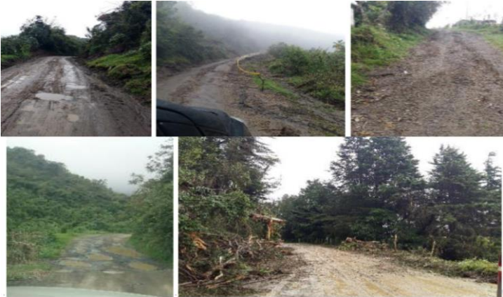
Imagen 18: Vías en mal estado en la parroquia de Nono
