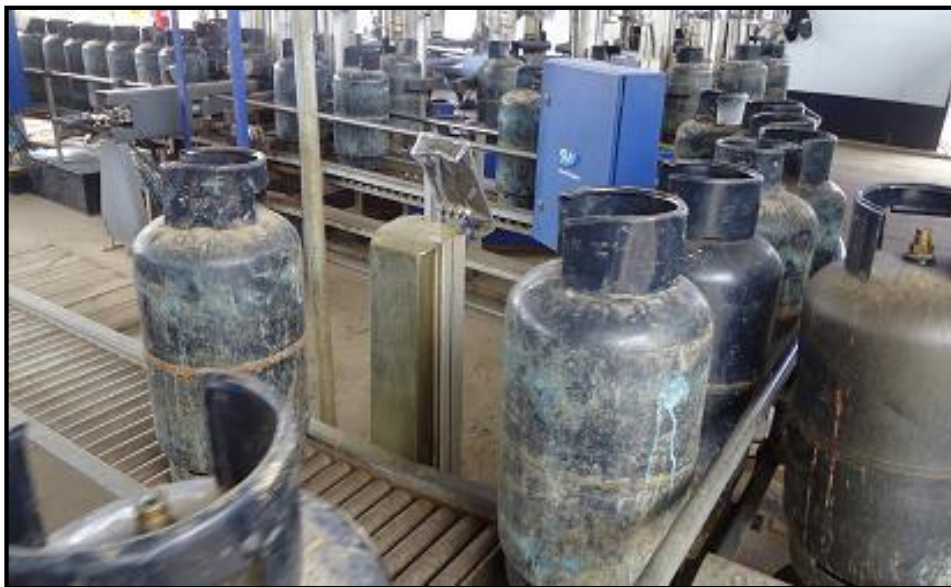
Rechazo automático del sistema, inspección del cilindro
