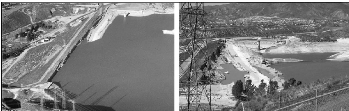
Figura 19. Presa de San Fernando. Izquierda: situación de la presa antes de la falla. Derecha: detalle del dique luego de la falla.
