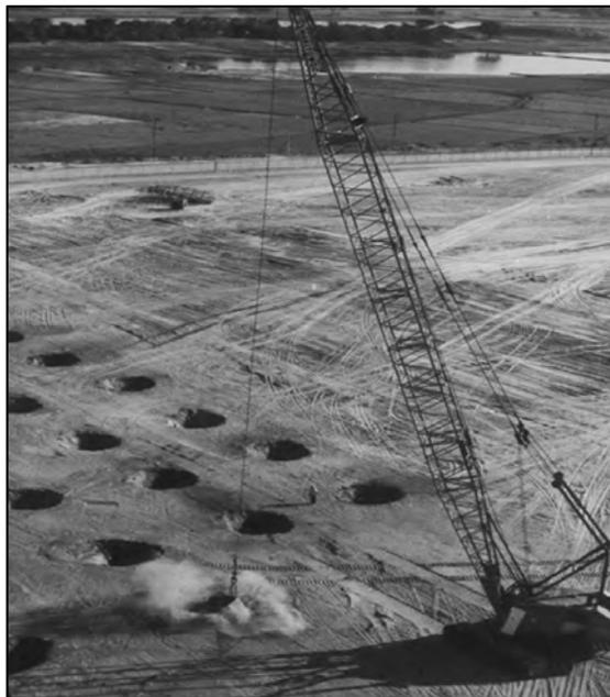
Figura 36. Proceso de compactación dinámica.
