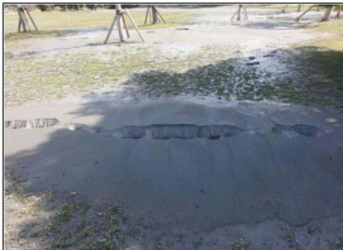
Figura 23. Volcán de arena a través de una grieta preexistente.
