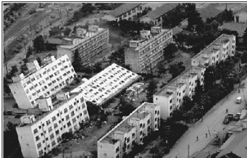
Figura 18. Edificio de departamentos en Kawagishi-cho que se inclinó y rotó debido a una falla de cimentación por la licuefacción.
