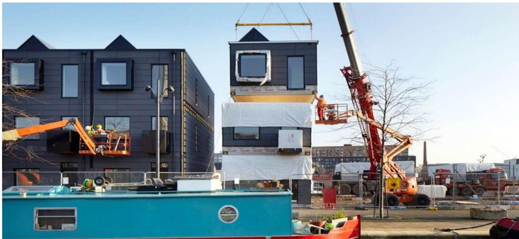
**Ilustración 1-10 Casas Modulares prefabricadas**
