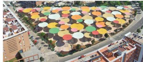
La diferente altura en los módulos permiten un traslape entre los mismos evitando la filtración de aguas lluvias entre los mismos y generando juegos de sombras.
