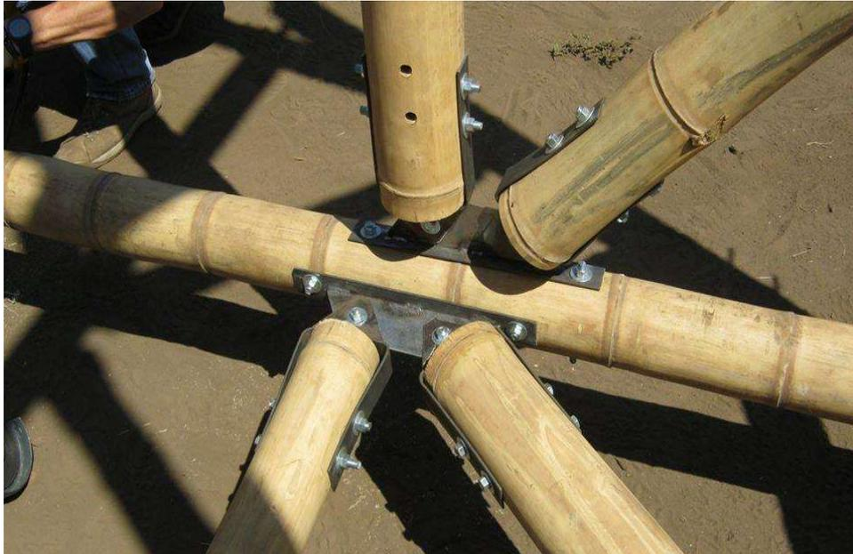
**Ilustración 1-33.** Unión de guaduas mediante ensambles metálicos
