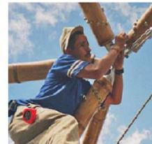
Los ensambles metálicos facilitan la unión y entre elementos de materialidad de guadua, pues al ser un material hueco su manejo es complejo, pero al utilizar mecanismos metálicos existentes se pueden generar estructuras resistentes.
