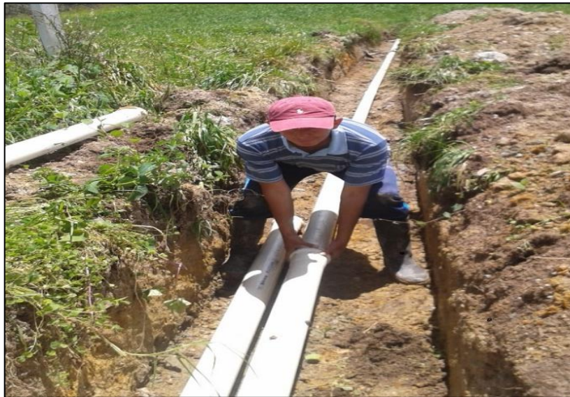
Figura 9 Instalación de la tubería
