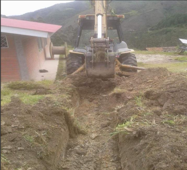
Excavación de la zanja
