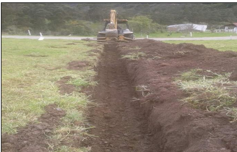
Figura 8 Excavación de la zanja
