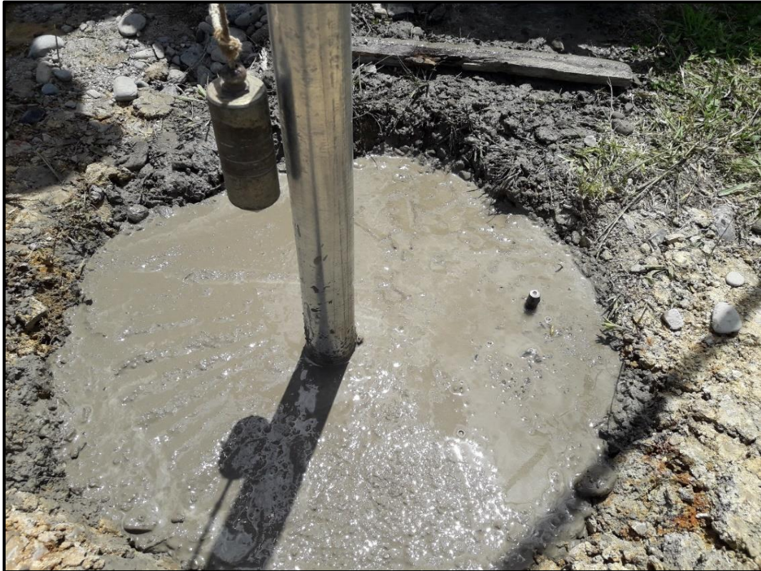
Figura 4.6.7. Fundición de la estructura con hormigón armado. Fuente: Los Autores. Elaboración: Los autores.
