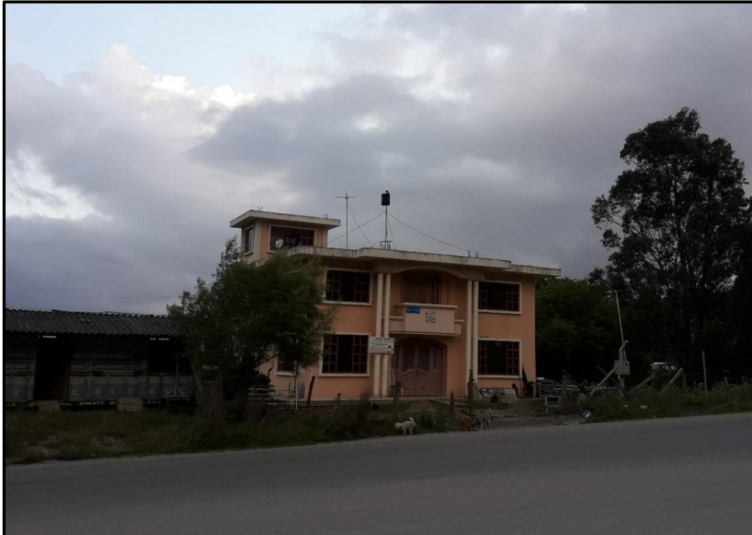
Figura 4.6.1. Estructura instalada para el gateway , vista desde la vía de integración barrial.
