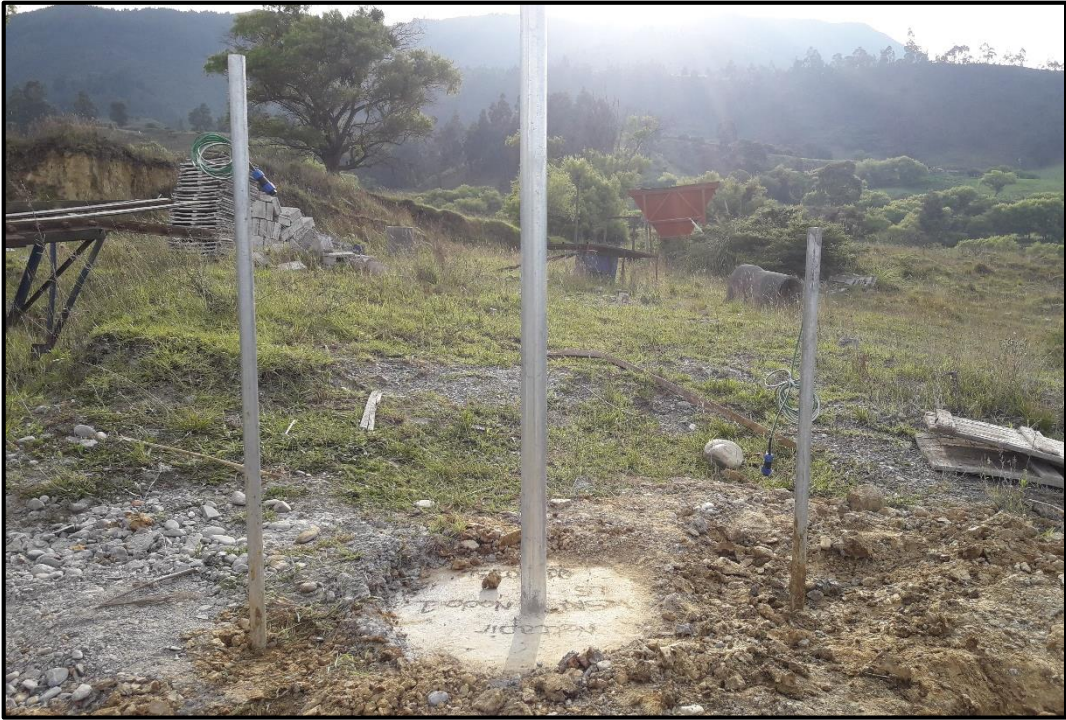
Figura 4.6.16. Instalación de los sensores de humedad a 1m y 1.5m de profundidad respectivamente. Fuente: Los Autores. Elaboración: Los autores.
