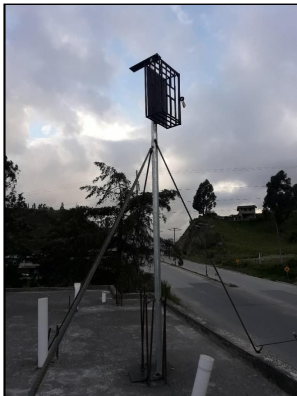
Figura 4.6.2. Instalación de la estructura para el gateway en la losa de una casa ubicada frente al terreno afectado, vista frontal.
