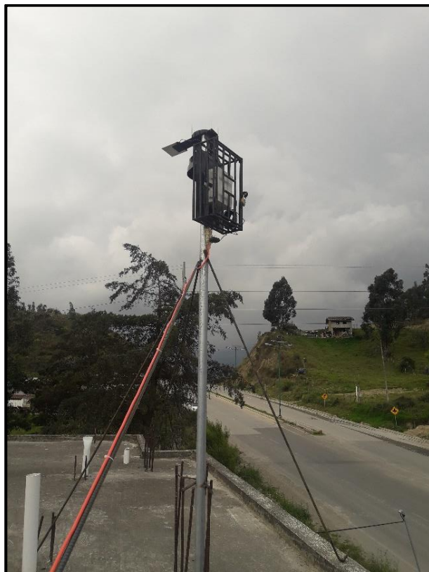
Figura 4.6.9. Gateway instalado, vista frontal.
