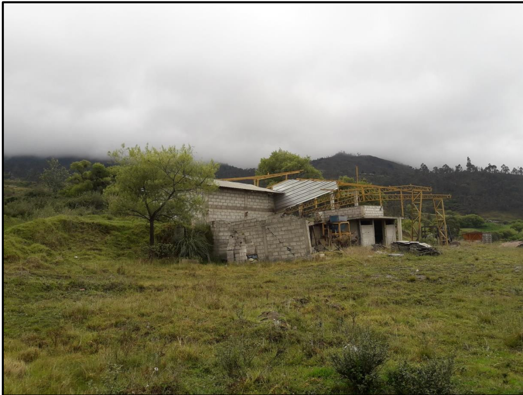
Figura 2.3.8. Vista lateral izquierda, construcción destruida por el desplazamiento del terreno. Fuente: Los Autores. Elaboración: Los Autores.
