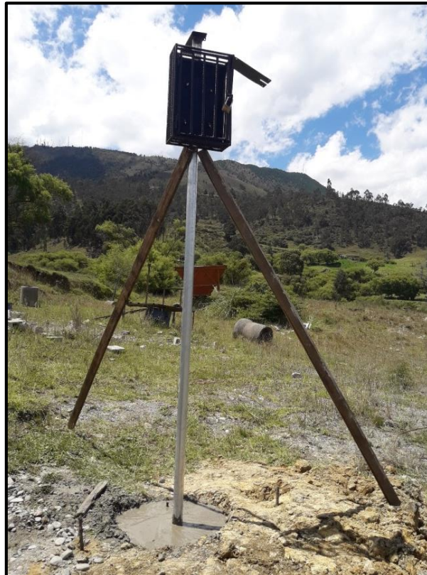
Figura 4.6.8. Estructura para el nodo adecuada en el punto del terreno correspondiente. Fuente: Los Autores. Elaboración: Los autores.
