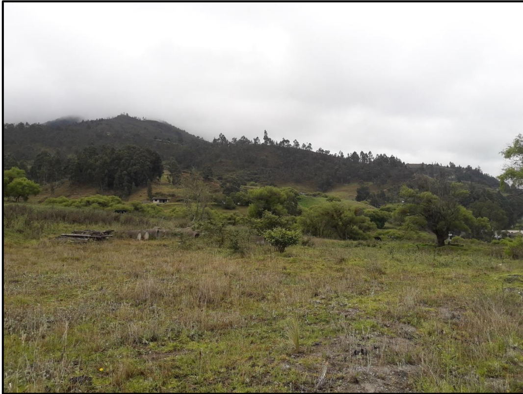
Figura 2.3.11. Extensión parcial de la zona de deslizamiento.
