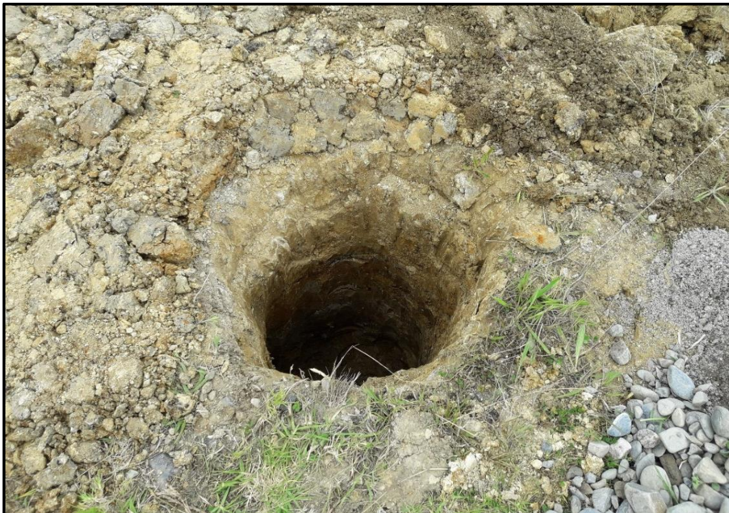
Figura 4.6.4. Excavación de un hoyo de 1.20m de profundidad para la instalación de la estructura para el nodo.
