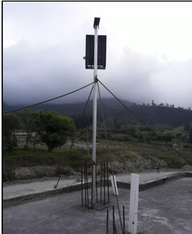
Figura 4.6.3. Instalación de una estructura para el gateway en la losa de una casa ubicada frente al terreno afectado, vista posterior.
