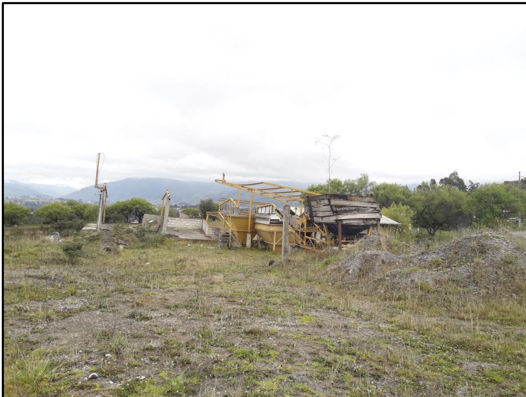
Figura 2.3.10. Vista posterior, construcción destruida por el desplazamiento del terreno.
