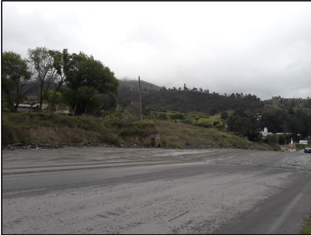
Figura 2.3.13. Efecto del deslizamiento sobre la vía de integración barrial.
