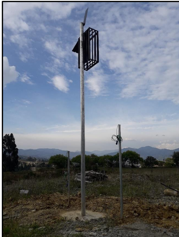
Figura 4.6.17. Sensores de humedad instalados a cada costado de la estructura del nodo. Fuente: Los Autores. Elaboración: Los Autores.
