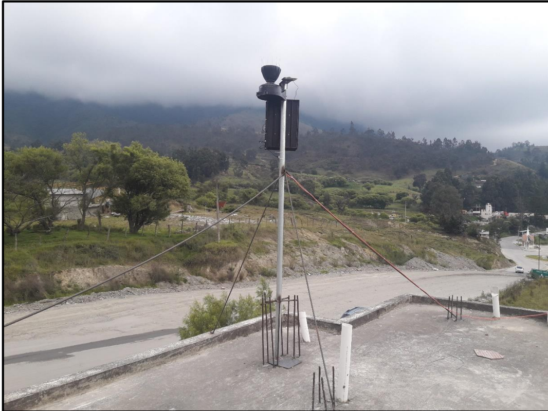
Figura 4.6.10. Gateway instalado, vista posterior.
