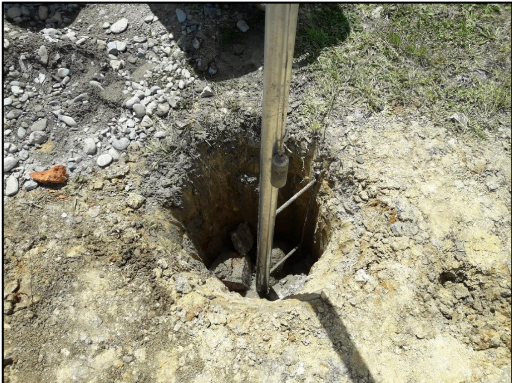
Figura 4.6.6. Adecuación de la base de hormigón armado para sujetar la estructura del nodo.
