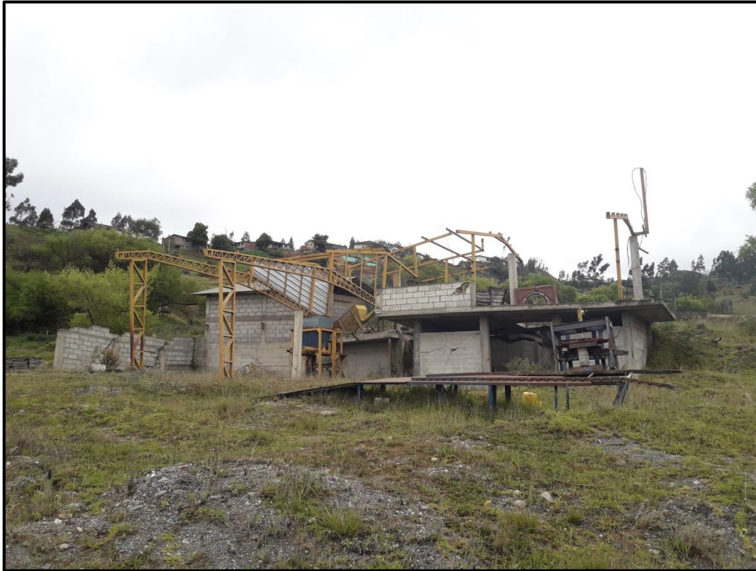
Figura 2.3.9. Vista lateral derecha, construcción destruida por el desplazamiento del terreno.
