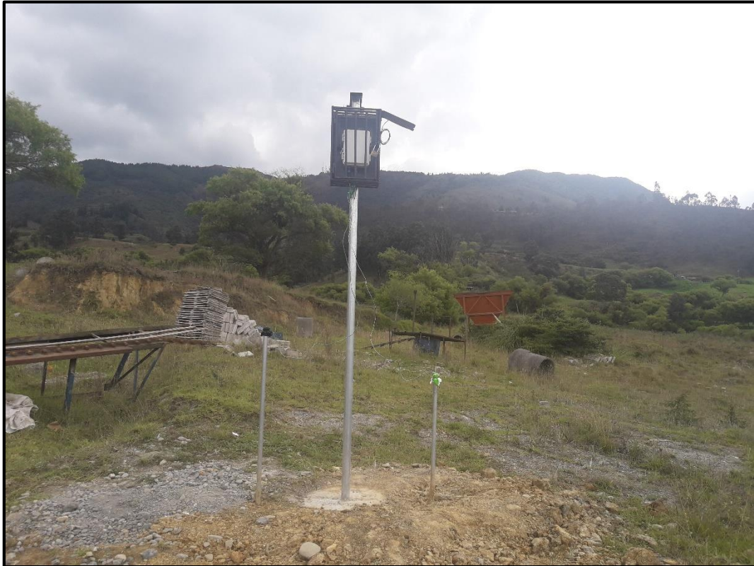
Figura 4.6.18. Nodo instalado, vista frontal. Fuente: Los Autores. Elaboración: Los Autores.
