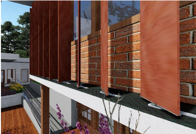
Figura 70 Detalle de persianas móviles. Fuente y elaboración: La autora
