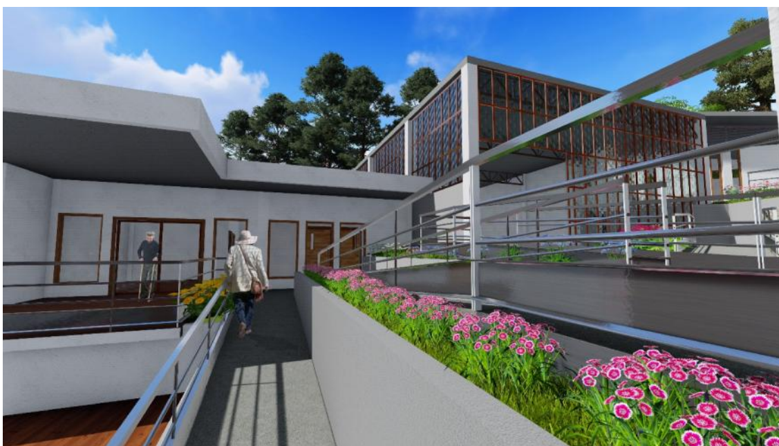
Figura 69. Vista hacia área médica. Fuente y elaboración: La autora
