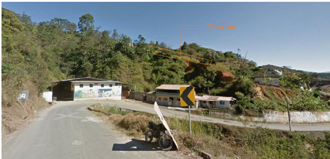
Figura 50. Vista desde la vía a Macará de medio natural que rodea el terreno.
