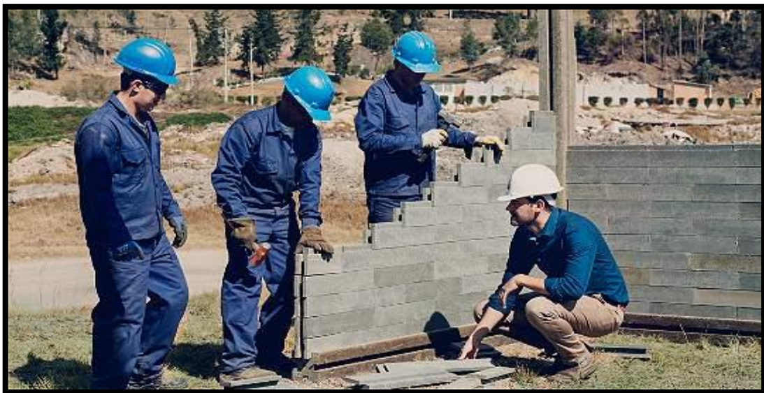
Figura 41: Construcción de pared con bloque tipo lego
