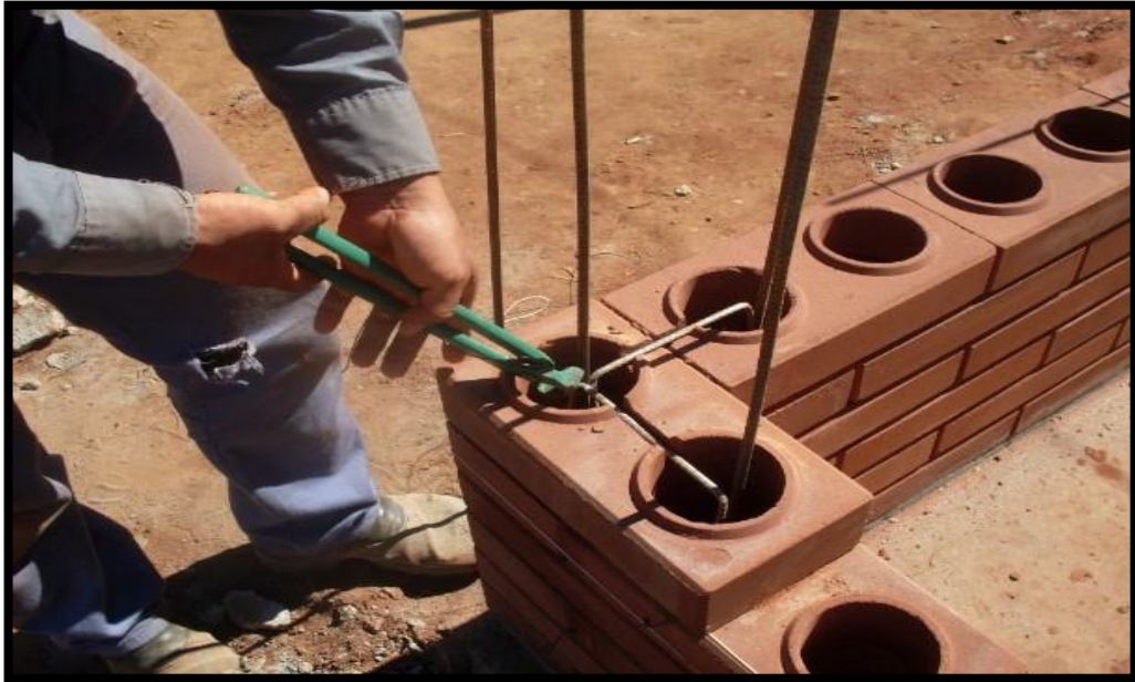
Figura 45: Ensamble del ladrillo tipo lego Fuente: El tiempo Elaboración: Caivinagua Samaniego, Danny Israel
