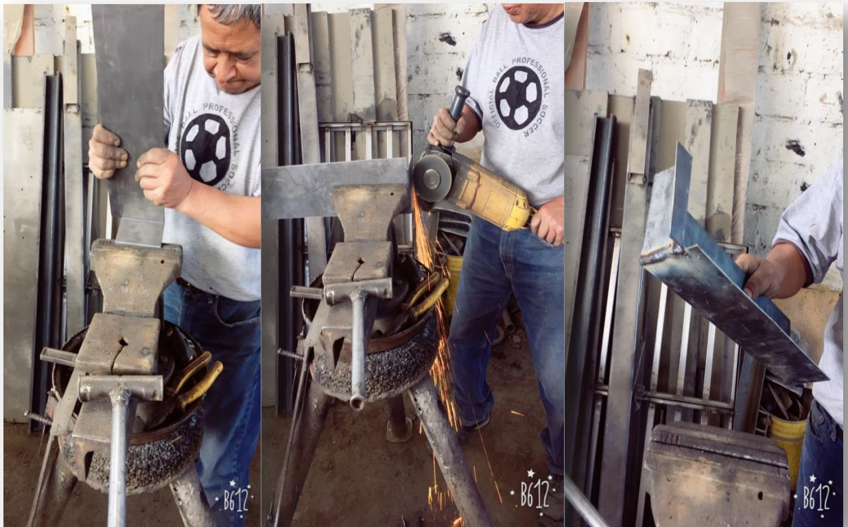
Figura 75: Doblado y soldado de placa metálica "A" y "B"
