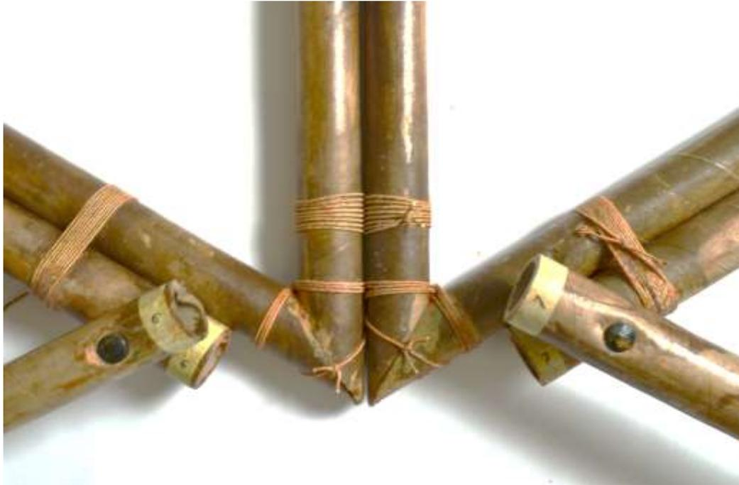
**Figura A.3\_** Detalle de unión entre estructura de cubierta y soportes tipo tijeras 2.
