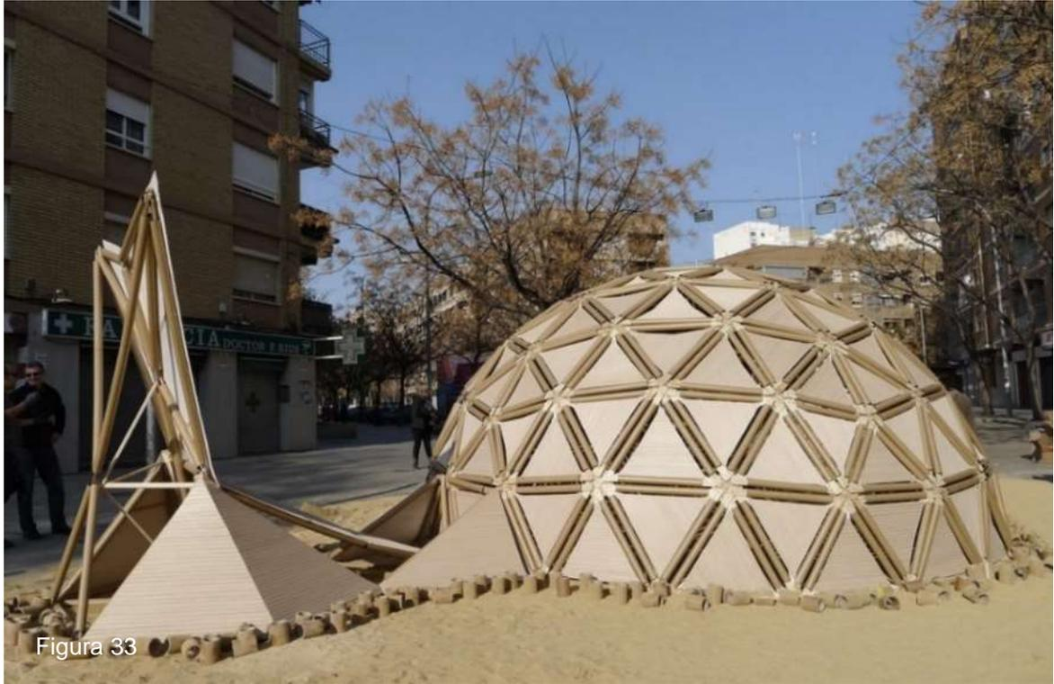
Se trata de una cúpula geodésica de frecuencia 4V, armada a partir de triángulos de diferentes colores, de tamaño variable y de fácil de ensamblaje sin herramientas.
