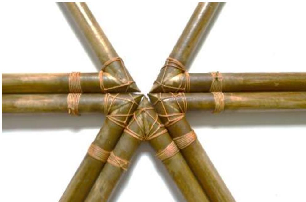
**Figura A.1\_** Detalle de amarre entre piezas triangulares que forman la estructura de cubierta.
