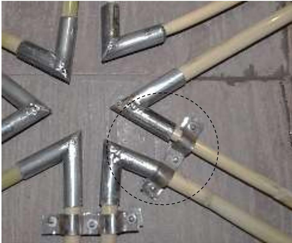
**Figura 88.** Colocación de abrazaderas dobles para unir las piezas de dos en dos
