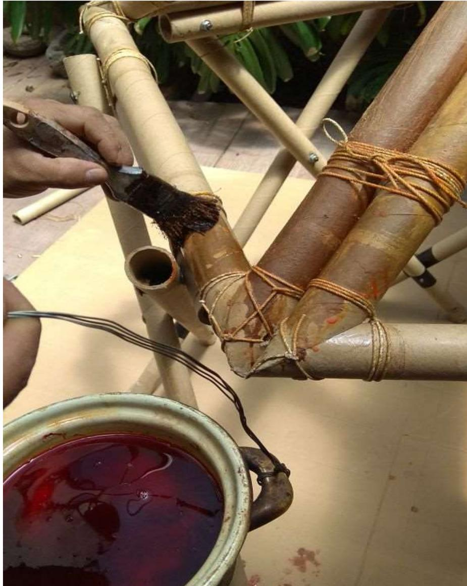
**Figura 110.** Colocación de parafina derretida en tubo de cartón
