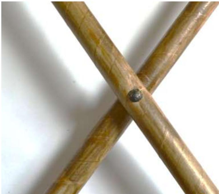
**Figura A.4\_** Detalle de unión entre tijeras.
