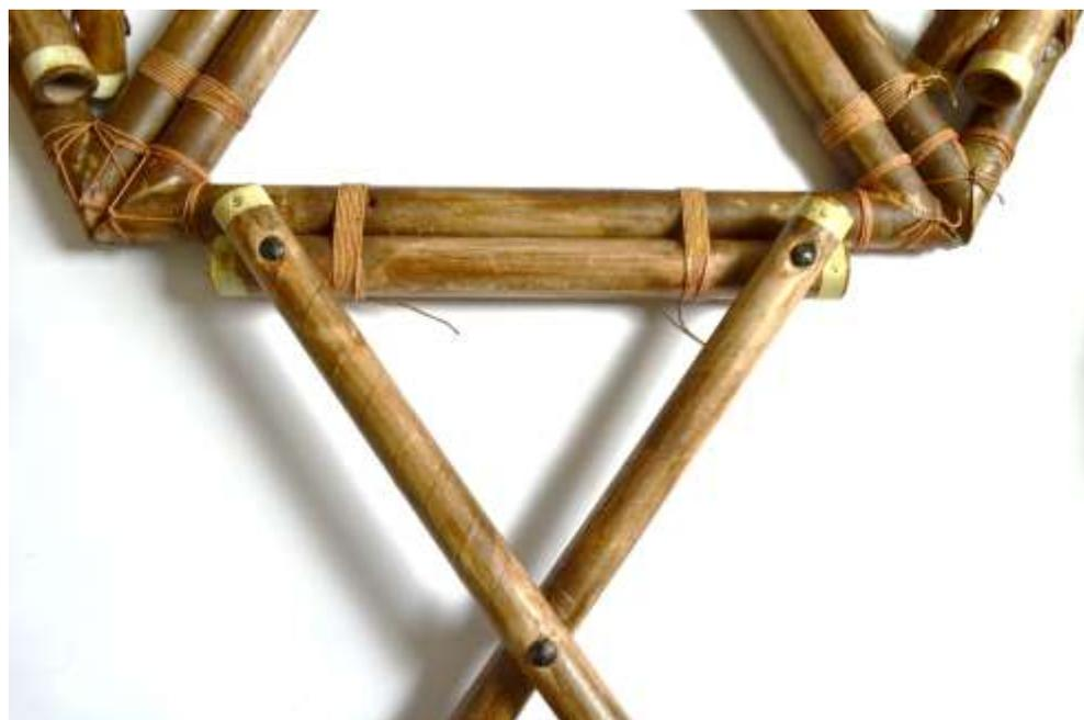
**Figura A.2\_** Detalle de unión entre estructura de cubierta y soportes tipo tijeras 1.
