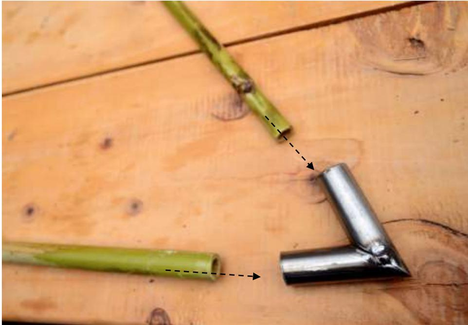
**Figura 85.** Unión Carrizo con ángulos metálicos
