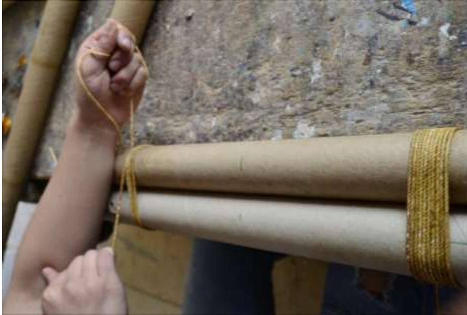
**Figura 97.** Amarre de tubo a la base del triángulo
