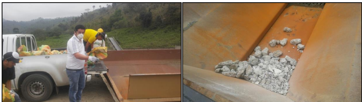
Figura 21. Colocación de los RCD de la clasificación 1 en la tolva Fuente: Planta de trituración del G.P.A.O. (Panupali) Elaborado por: El autor
