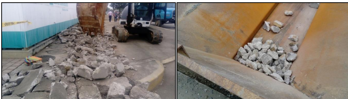
Figura 23. Muestra X de RCD para comparación de resultados Fuente: Acera en demolición en la ciudad de Machala Elaborado por: El autor
