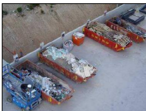
Figura 3. Separación y almacenamiento de residuos Fuente: (Arce & Tapia, 2014) Elaborado por: (Arce & Tapia, 2014)
