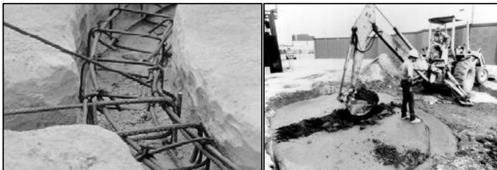
Figura 13. Relleno Fluido excavado de acuerdo a su resistencia
