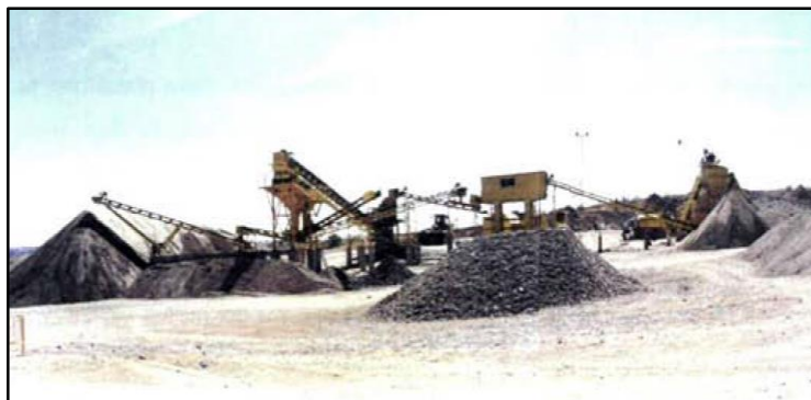
Figura 6. Planta fija de tratamiento de residuos de construcción y demolición
