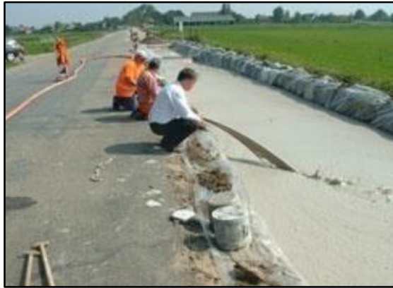
Figura 11. Relleno Fluido usado como sub-base Fuente: (Mejía, 2010) Elaborado por: (Mejía, 2010)
