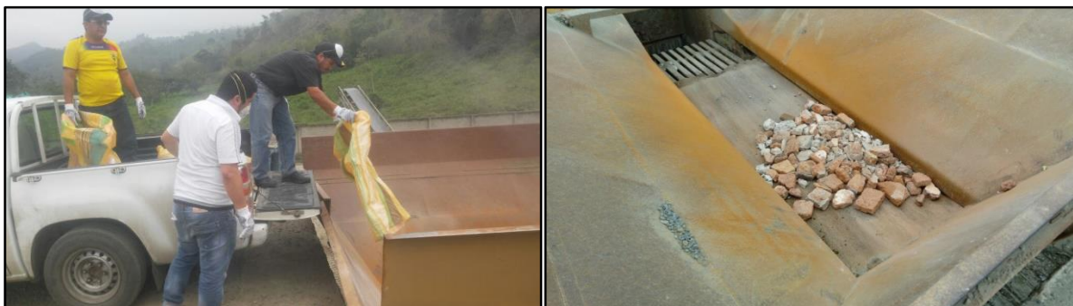
Figura 22. Colocación de los RCD de la clasificación 2 en la tolva Fuente: Planta de trituración del G.P.A.O. (Panupali) Elaborado por: El autor
