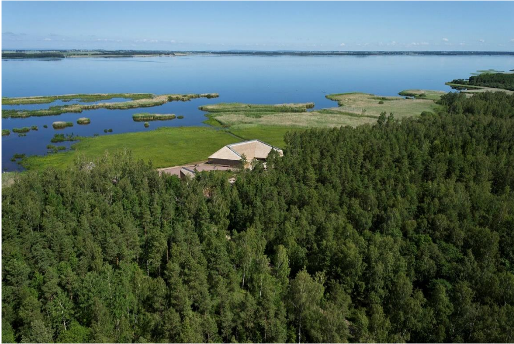
Imagen 6. Fotografía exterior del proyecto Naturum Tarken de Gert Wingardh en Suecia. Fuente.- https://www.plataformaarquitectura.cl/cl/627980/naturum-takern-wingardhs/5420ec0ac07a800de50000ab-naturum-takern-wingardhs-foto_2015 Elaboración: Autor
