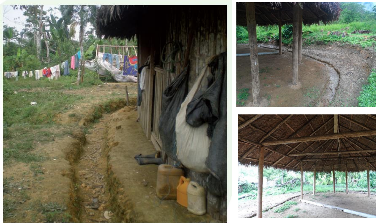
Imagen 19. (Iz.) Fotografía de zanja alrededor de la vivienda. (Der.) Estructura de la edificación. Fuente: Tesis de grado de Ximena Cuenca, 2011, pag. 50 Elaboración: Autor.
