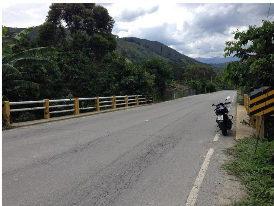
Figura 24. Puente de hormigón y pasamano de acero Km 19+750 de la vía en estudio.
