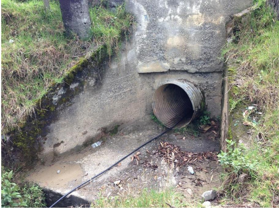
Figura 19. Alcantarilla en buen estado en el Km 3+120 de la vía en estudio.
