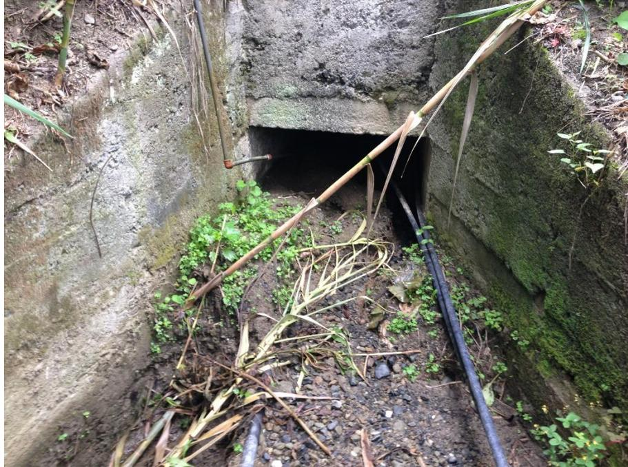
Figura 21. Alcantarilla azolvada en el Km 23+550 de la vía en estudio.
