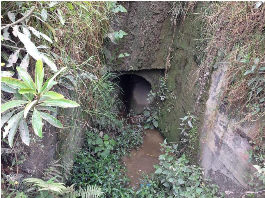
Figura 20. Alcantarilla en estado regular en el Km 8+210 de la vía en estudio.
