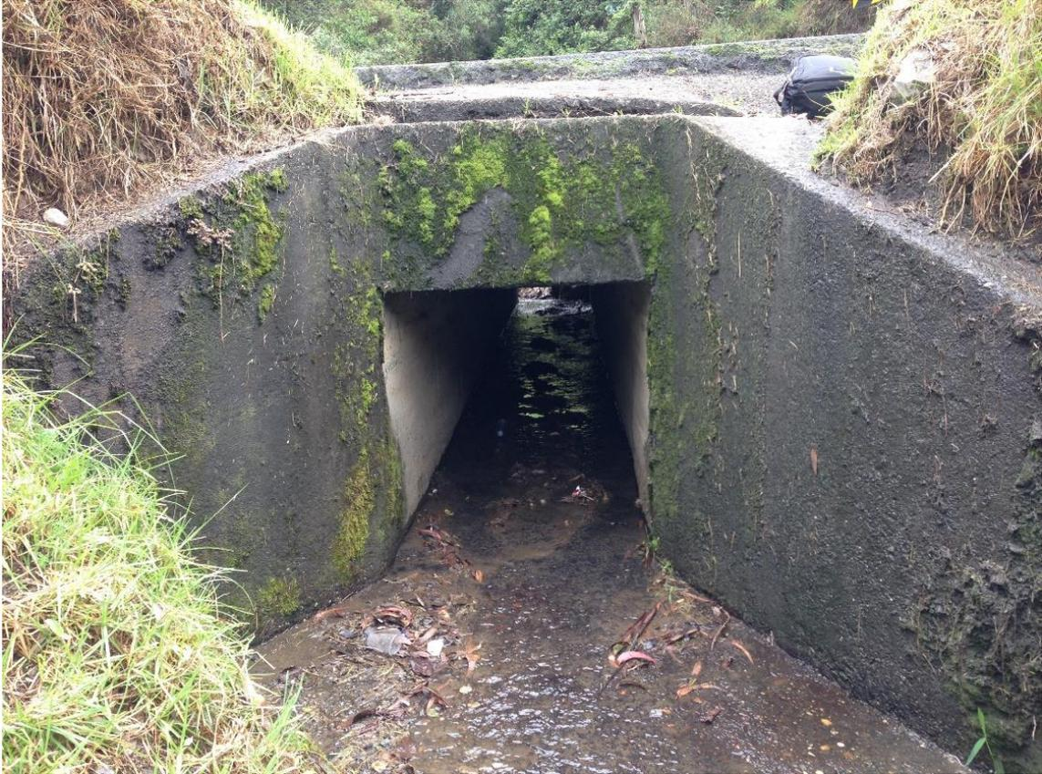
Figura 1. Alcantarilla rectangular de hormigón Km 0+990 del tramo Loja – Malacatos.
