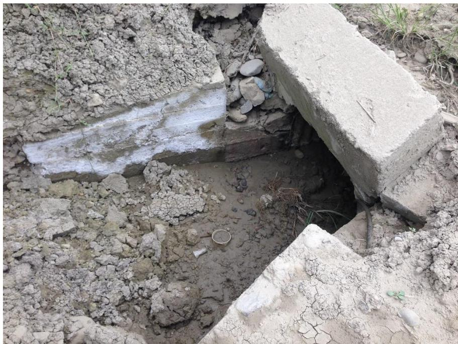
Figura 22. Alcantarilla mal estado en el Km 29+450 de la vía de estudio.
