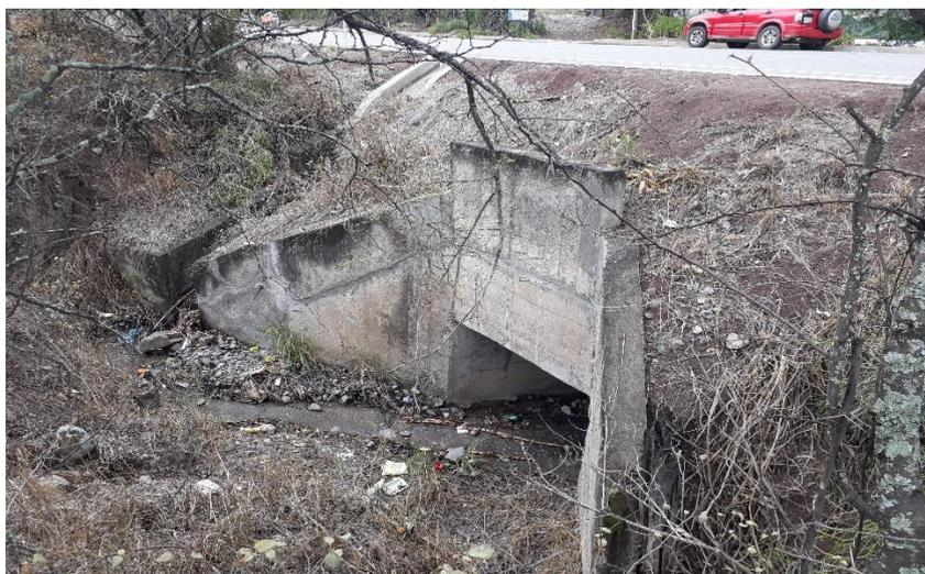
Fotografía 12. Alcantarilla de Hormigón Rectangular Absc: 35+629
