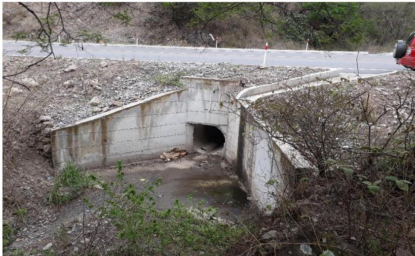
Fotografía 11. Alcantarilla de Hormigón Circular Absc: 30 + 762
