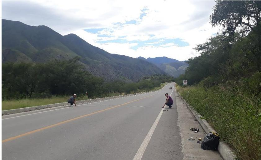
Fotografía 4. Registro del Ancho de la Superficie de Rodadura
