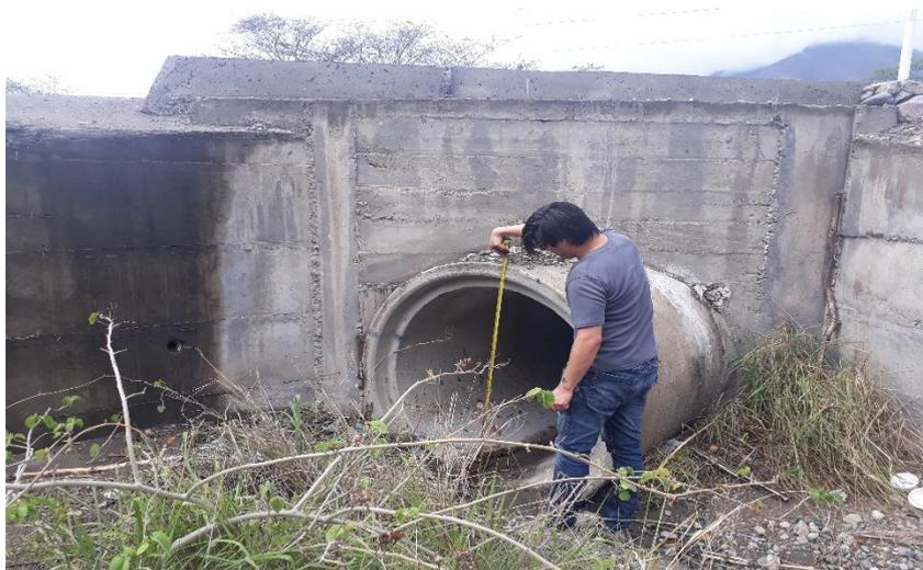
Fotografía 9. Registro de Diámetros de las Alcantarillas
