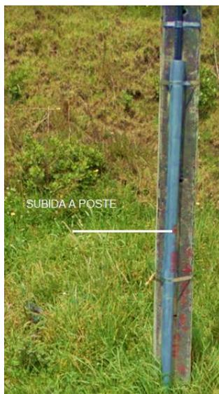
Figura 21. Ducto de subida a poste.
