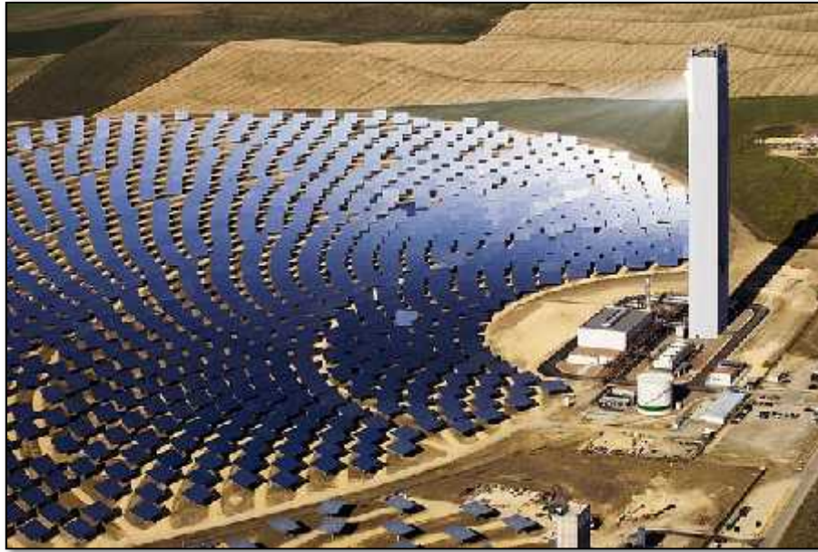
Figura 2 Central solar térmica a altas temperaturas con heliostatos. Fuente: https://solar-energia.net/energia-solar-termica/alta-temperatura Elaboración: El Autor.
