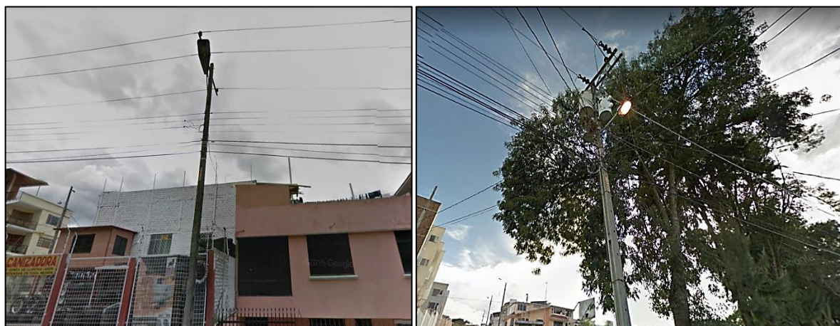
Figura 42 Postes del sector Fuente: Elaboración propia Elaboración: Elaboración propia
