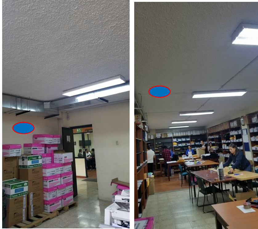
Figura 1. Sistema de detección de incendio
